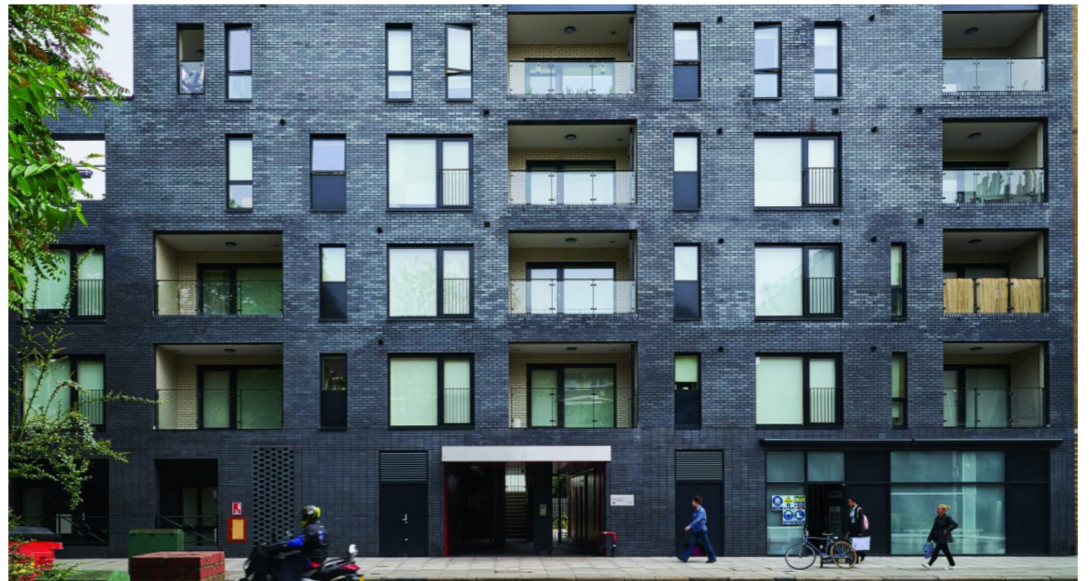
169 Long Lane / Long Lane, SE1
