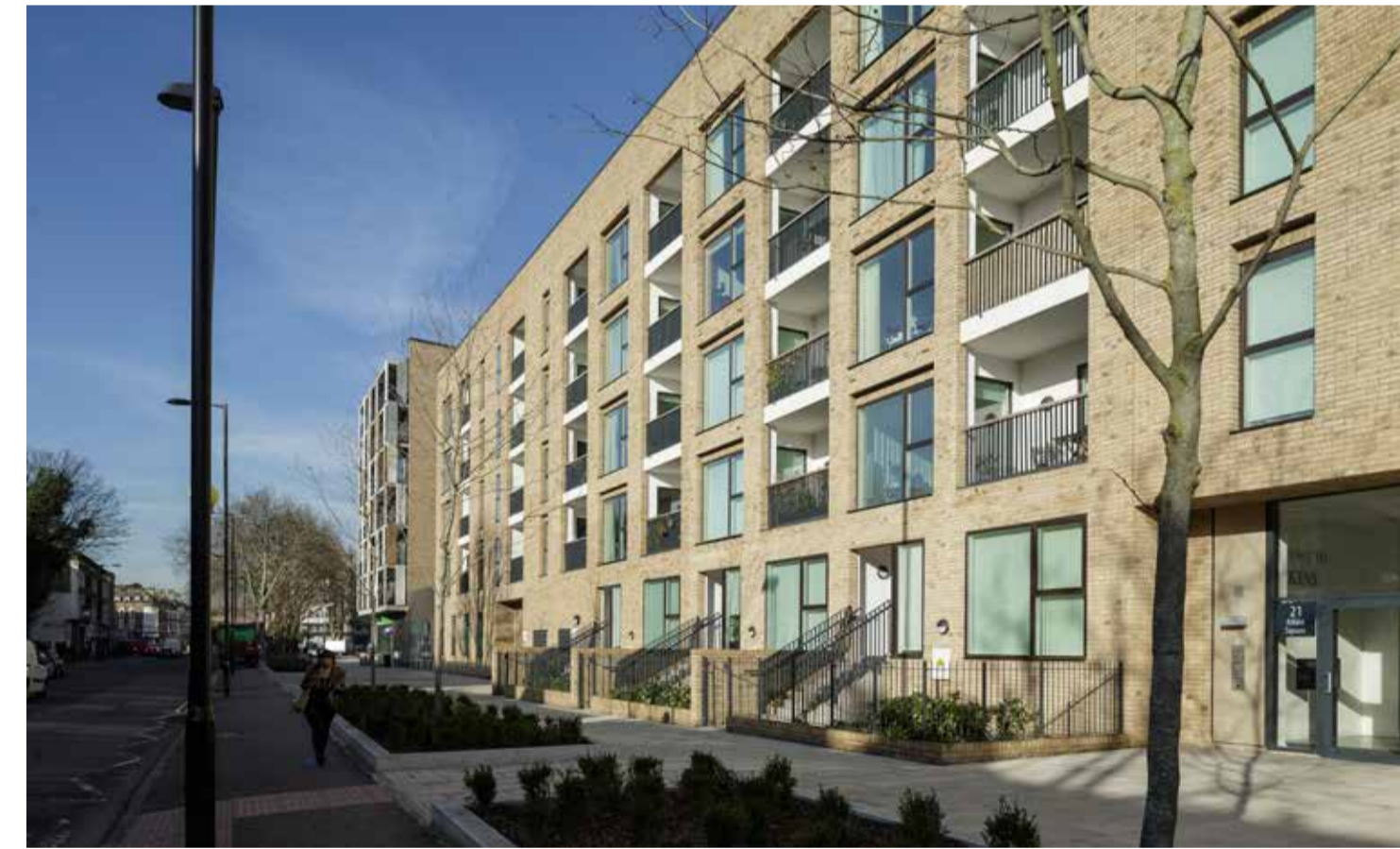
Pembury Circus / Hackney, FBM Architects
