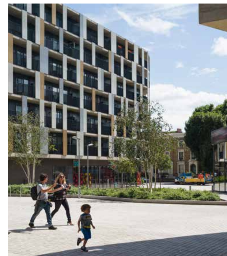
Pembury Circus / Hackney, FBM Architects
